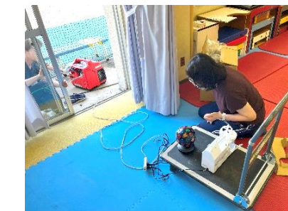
非常用電源の確認（救護）
